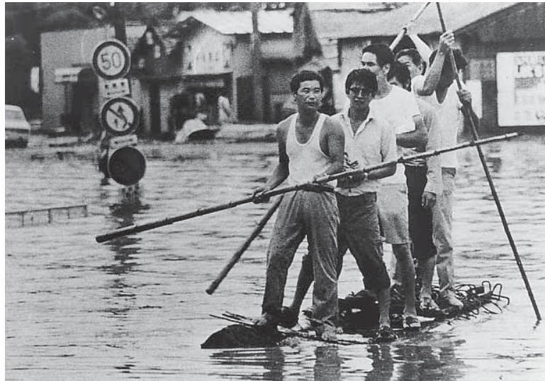
台風5号による豪雨で浸水 —北原(昭和50年)
