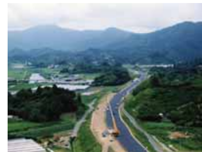
四国横断自動車道(伊野～須崎間)着工(平成4年)
