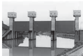
波介川水門完成（昭和55年）
