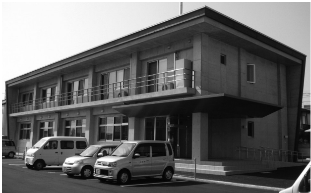
防災センター
